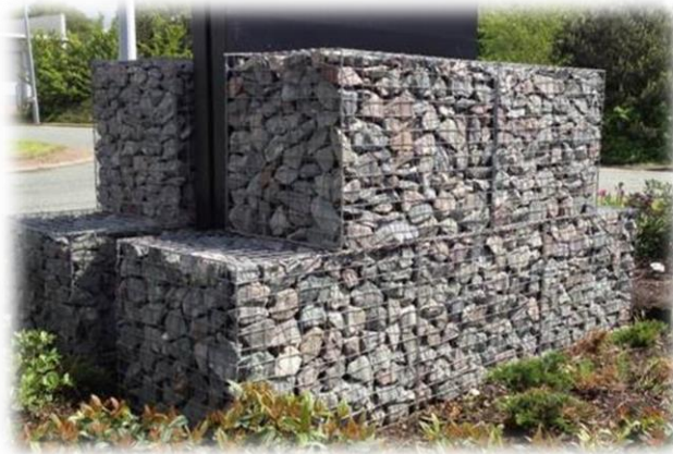
Figure 6: Exemple de muret en gabion
